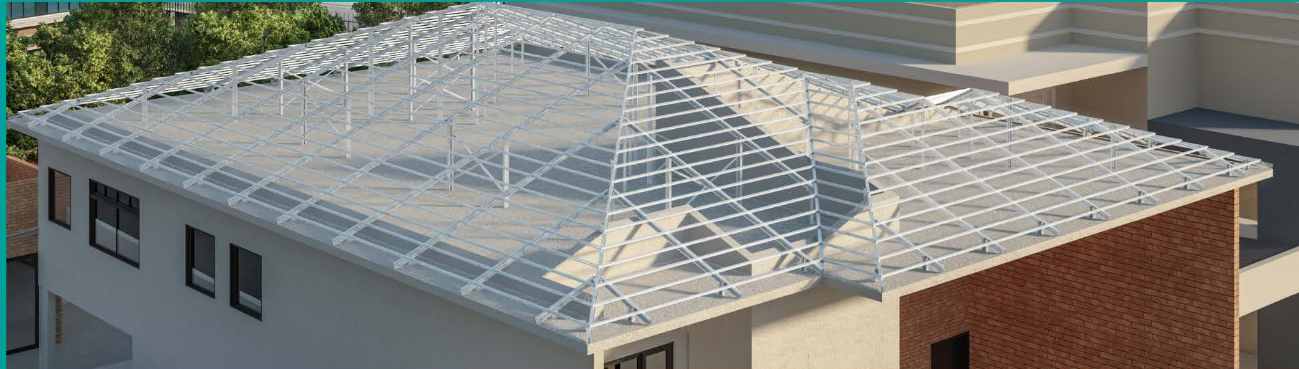
ESTRUTURA METÁLICA PARA TELHADO
